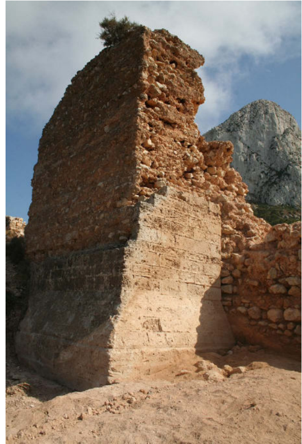
Fig. 8: Vista de les restes de la torre campanar de l'església Beata Santa Maria d'Ifac. ADT MARQ.
